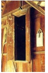
ภาพล่าง แสดง เปรียบเทียบ ลักษณะการเปิด ประตู หน้าต่าง ที่มี แกนประตูเป็นสลักเดือยฝัง ( Pivot ) เหมือนกัน
