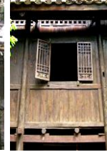
ภาพล่าง แสดง เปรียบเทียบ ลักษณะการเปิด ประตู หน้าต่าง ที่มี แกนประตูเป็นสลักเดือยฝัง ( Pivot ) เหมือนกัน
