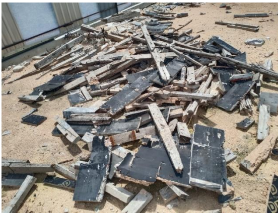
ภาพที่ 1 แสดงไม้ตัดดําที่สูญเสียในงานก่อสร้าง
