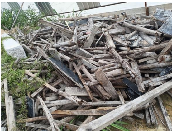
ภาพที่ 2 แสดงไม้ยูคาที่สูญเสียในงานก่อสร้าง
