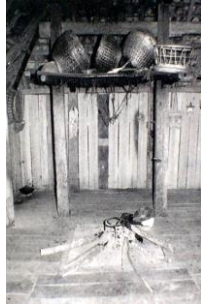
แม่เตาไฟ ในเรือนใต้-ไทย รูปซ้ายมือ เป็นแม่เตาไฟ และชั้นเก็บ ของเหนือนเตา ในเรือนสิบสองปันนา และรูปขวา เป็นแม่เตาไฟ และครัวในเรือนล้านนาทั่วไป ความแตกต่างของแม่เตาไฟ มี ลักษณะนำมาวาง เพื่อสะดวกในการเคลื่อนย้าย
