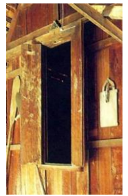
ภาพล่าง แสดง เปรียบเทียบ ลักษณะการเปิด ประตู หน้าต่าง ที่มี แกนประตูเป็นสลักเดือยฝัง ( Pivot ) เหมือนกัน
