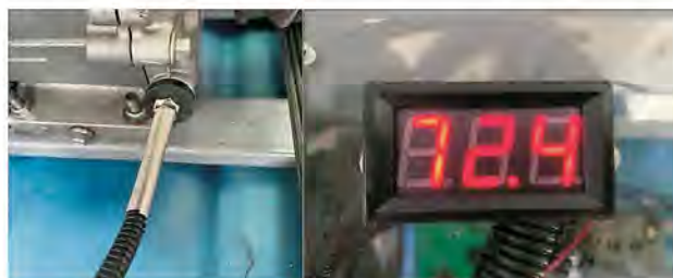
ภาพที่ 4 การติดตั้งอุปกรณ์วัดอุณหภูมิน้ำมันหล่อลื่น
