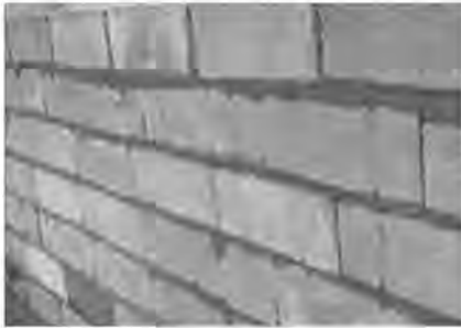
ภาพที่ 25 ลักษณะการเรียงตัวแบบไม่เสมอกันของผนัง จากคอนกรีตบล็อกผสมผงเซรามิกเหลือทิ้ง
