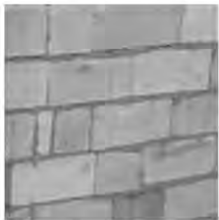
ภาพที่ 24 การก่อและยึดคอนกรีตบล็อกผสมผงเซรามิกเหลือทิ้ง เป็นผนังด้วยปูนก่อ
