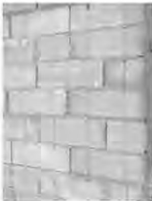
ภาพที่ 26 ลักษณะของผนังที่ก่อด้วยคอนกรีตบล็อก ผสมผงเซรามิกขนาดขอบเฟรม
