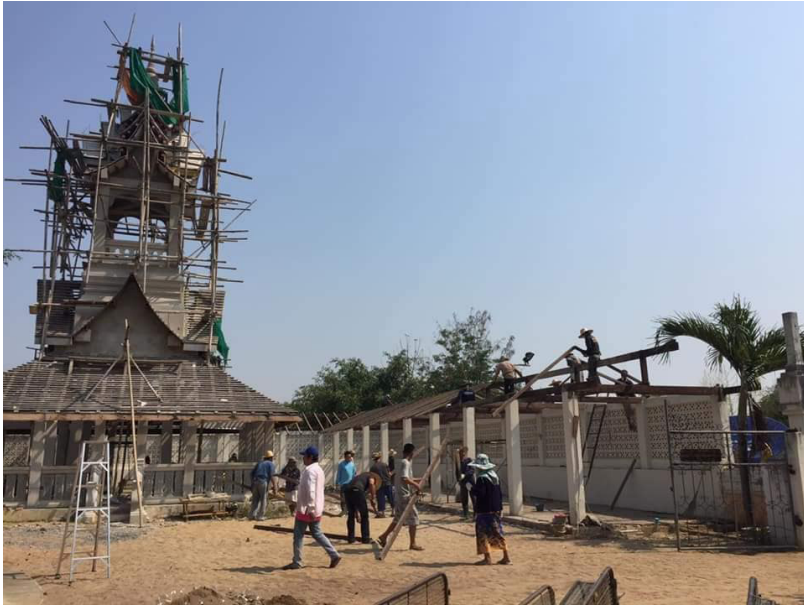
ภาพที่ 7 การปรับปรุงบูรณะปฏิสังขรณ์ศาลาบาตร
