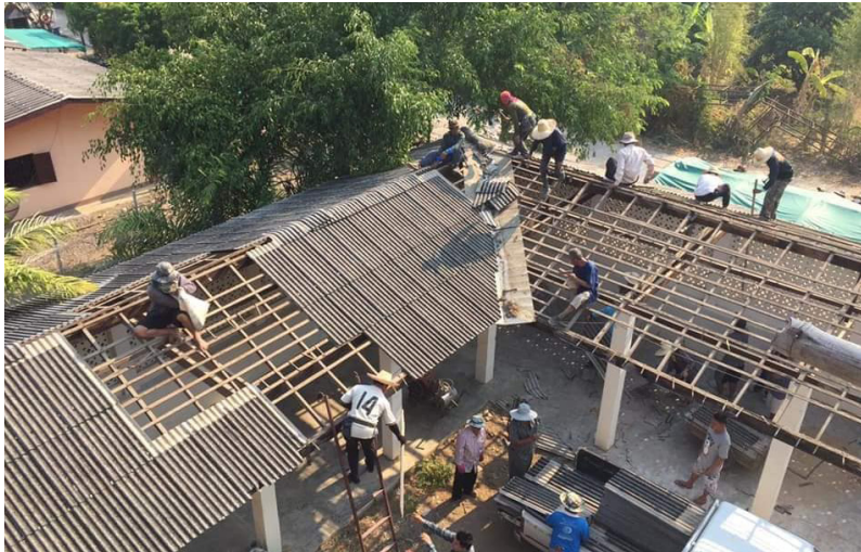
ภาพที่ 8 ปรับปรุงบูรณะปฏิสังขรณ์ศาลาบาตร
