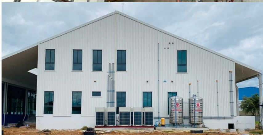
ภาพที่ 2 การติดตั้งชุดคอยล์ร้อนอาคารสำนักงาน บริษัท วินโดว์ เอเชีย จำกัด (มหาชน)
