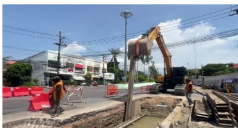
(a) การขุดบ่อเชื่อมและค้ำยันบ่อ
